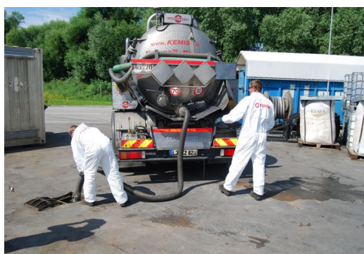
Iz kanala se izčrpa tekočino v cisterno
