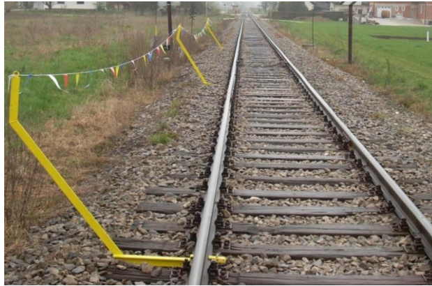
Slika 31: Način namestitve signalne vrstice na kotni profil, ki se pritrdi na nogo tirnice
