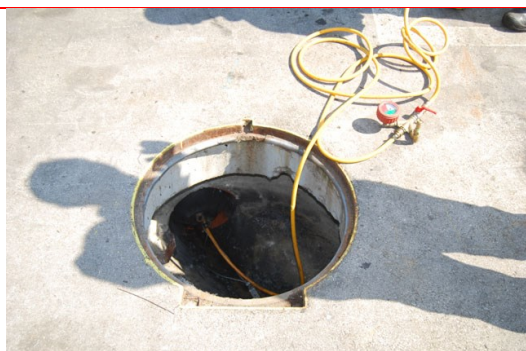
Kanal odtočnega jaška se zapre z balonom, s katerim se v jašku zapolni odtočna cev in prepreči iztok odpadne tekočine naprej v kanalizacijo.
