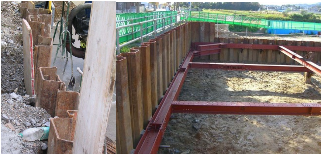
Slika 10: Jeklene zagatnice
