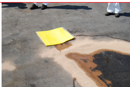
Odtočni kanal se pokrije s krpo, ki veže nase nevarno tekočino
